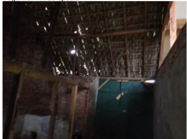
Schuurgedeelte van de woning
