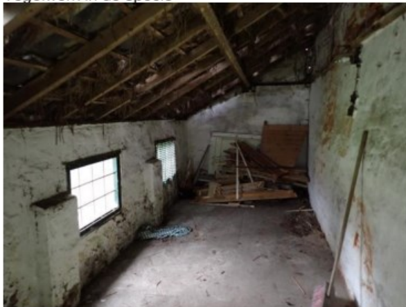
Onder de aanbouw achter
