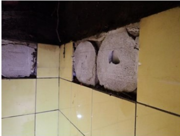
Tegelwerk in de specie
