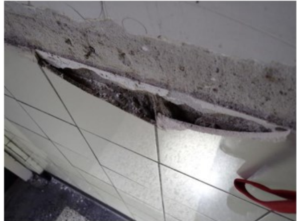
Tegelwerk in de specie
